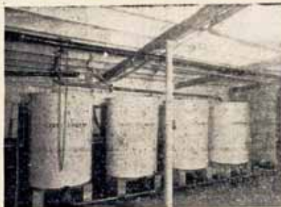
In de gistingsschalen, op bovenstaande foto, heeft de gisting plaats
