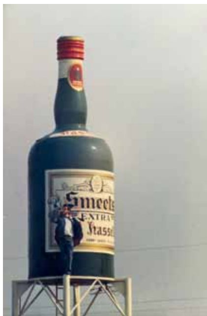
De opvallende fles op het dak van de bedrijfsgebouwen in de Sasstraat. De fles werd verlicht met 160 lampen die om de twee jaar manueel vervangen werden. Privécollectie.
