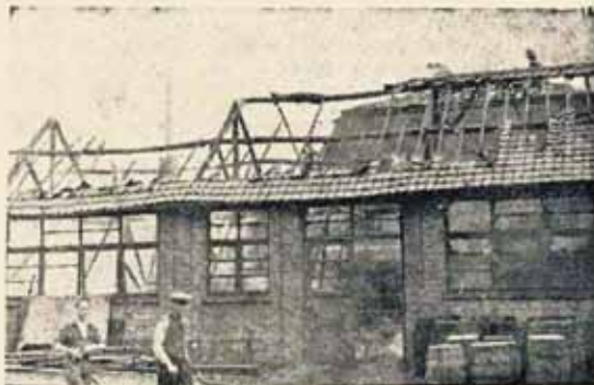
De totaal vernielde opslagplaats na de brand.
