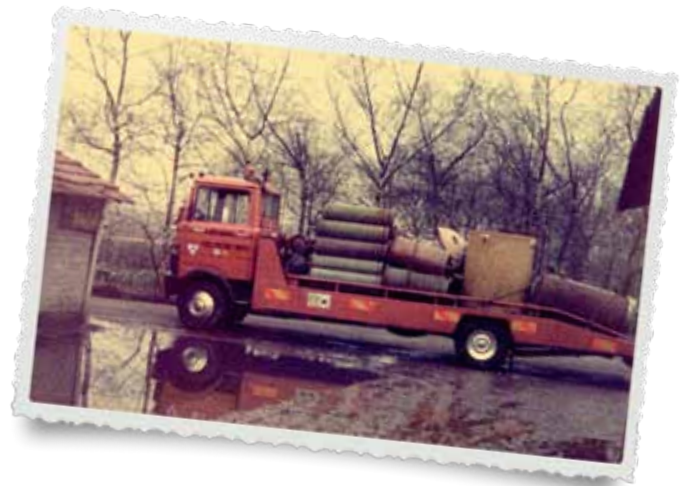
Grote ontmantelde distilleerinstallaties worden met vrachtwagens afgevoerd naar het entrepot.
